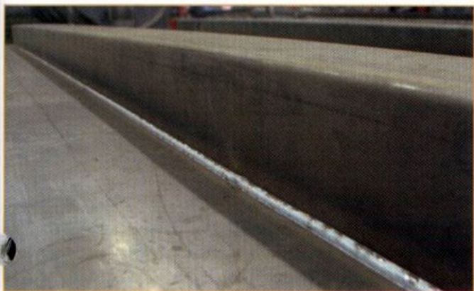
Rys. 4 Spoina ciągła i jednakowa na długości kilku metrów
